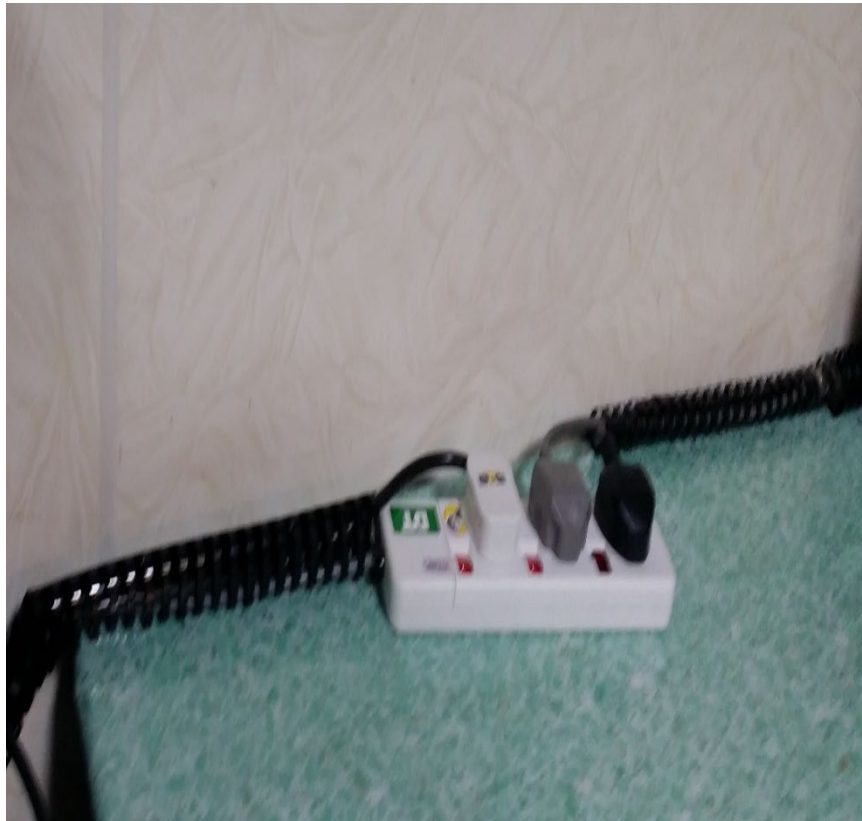
Kabel yang diikat dengan kemas
